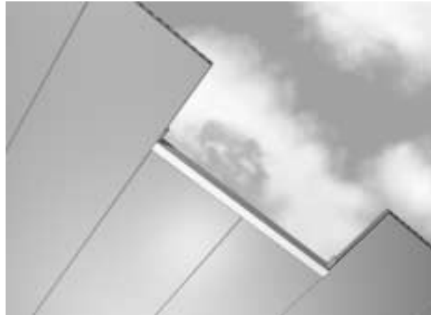
Oud situatie: raveelijzer in het zicht
